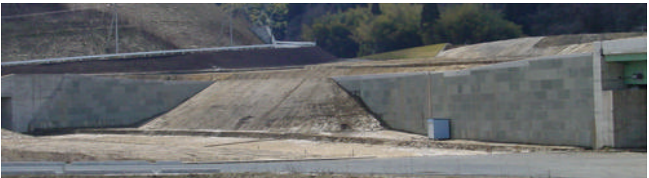
写真-1 完成状況
