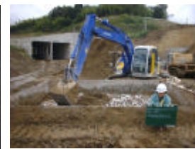
写真 - 3 バックホウによる改良土の攪拌混合状況
