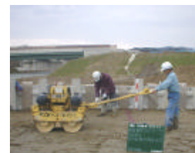
写真 - 4 改良土の転圧状況
