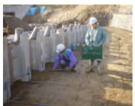
写真 - 5 バールと補助アンカー
