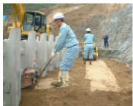
写真 - 4 改良土の転圧状況
