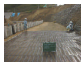
写真 - 6 ジオグリッド敷設状況
