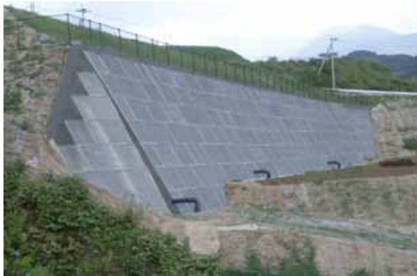
写真-6 施工事例 5.1 施工完了
