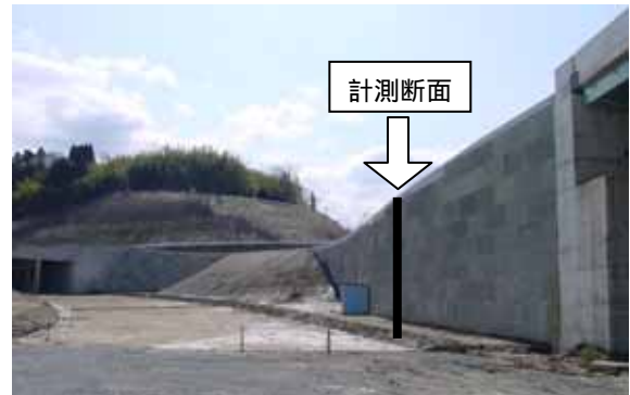
写真-5 ジオグリッドのひずみ計測実施適用現場
