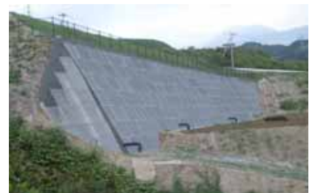
写真-3 造成工事への適用事例(5分勾配)
