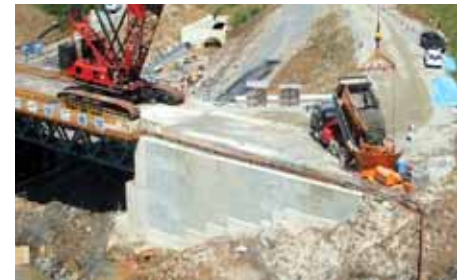
写真-2 橋台袖部土留めへの適用事例
