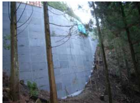
写真-7 施工事例 5.2 施工完了
