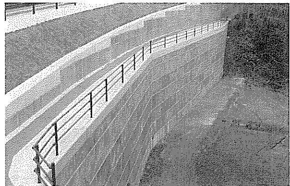
図-7.15 補強材と壁面材の結合部に改良土を用いる補強土壁の概要
